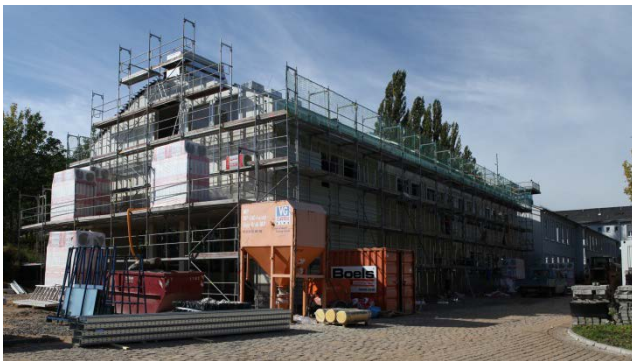
Rohbau des Technikums am Fraunhofer IVI © Fraunhofer IVI
